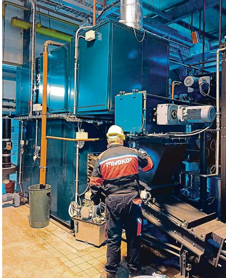
JEDNOTKA KERAMICKÉHO SPALINOVÉHO FILTRU PRO KOTLE S VYSOKÝM VÝKONEM SE POUŽÍVÁ ZAPOJENÍ VÍCE JEDNOTEK DO BATERIÍ.
